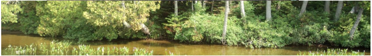
Figure 21 : Érosion aux pieds de la rive; démarcation des hautes eaux sur les arbres ou des vagues des bateaux?
